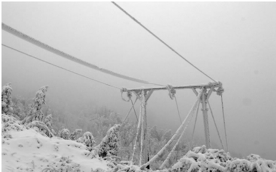
图 2.5 冰雪压垮线缆事故
