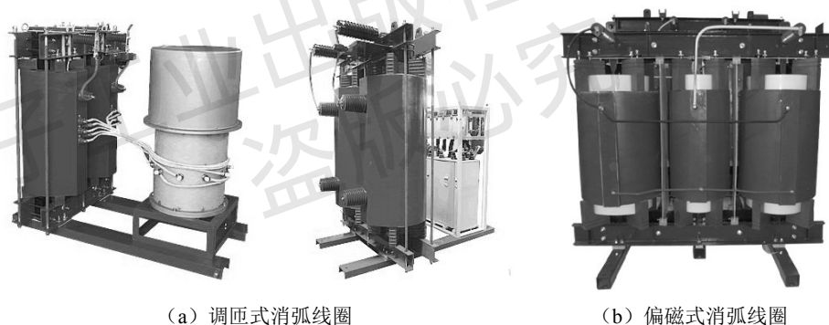
图 1-7 消弧线圈实物图
