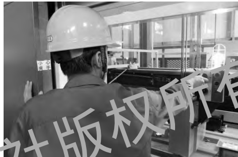
图 3-11 复位轿顶急停开关 (1)
