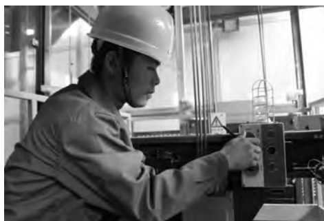
图 3-20 复位轿顶急停开关 (2)
