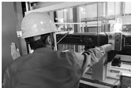
图 3-10 打开轿顶检修开关
