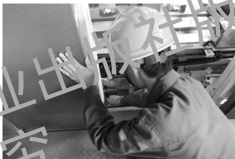
图 3-21 固定顶门器 (1)
