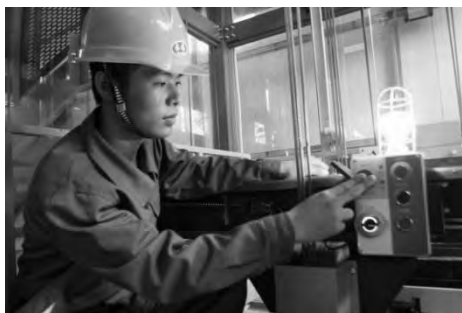
图 3-17 将轿顶急停开关置于停止位置
