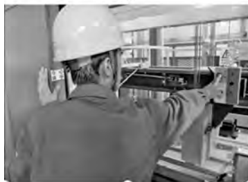
图 3-7 打开轿顶灯及按下轿顶急停开关
