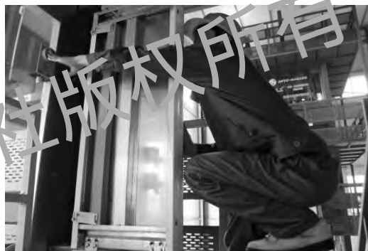
图 3-32 按下底坑上急停开关
