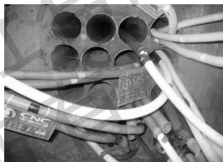
(b) 管道敷设
